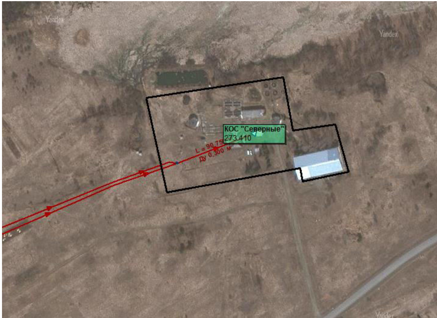
Общий вид сооружения водоотведения – КОС «Северные»
