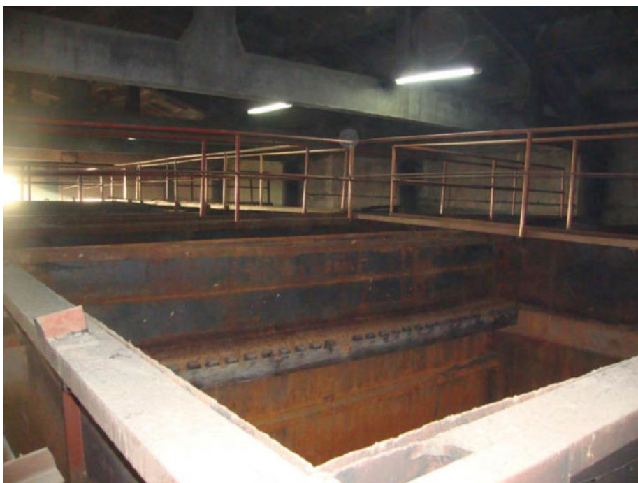
Рисунок 1.1.11 - Контактные осветлители
