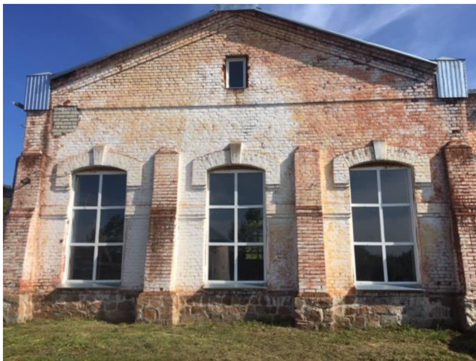
Рисунок 1.1.6 - Здание насосной станции первого подъема
