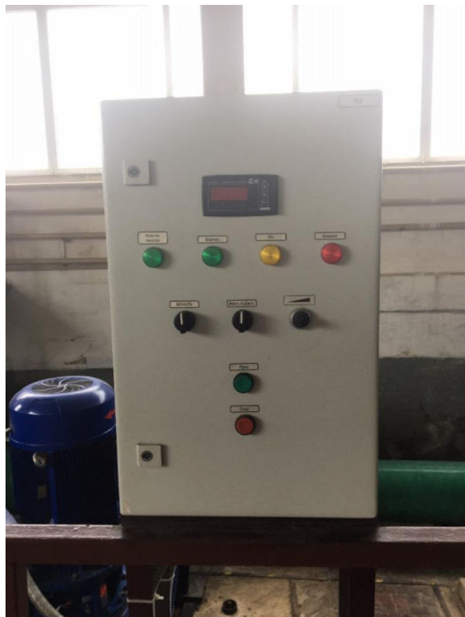
Рисунок 1.1.16 – Пульт управления насосами в НФС
