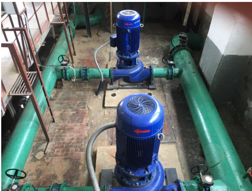
Рисунок 1.1.14 - Насосы KSB Etaline
