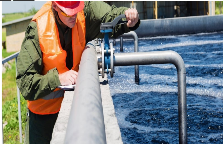
СТРОИТЕЛЬСТВО ОЧИСТНЫХ СООРУЖЕНИЙ КАНАЛИЗАЦИИ
